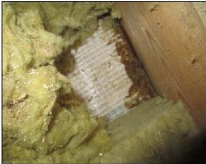
Мінвата нещільно встановлена
