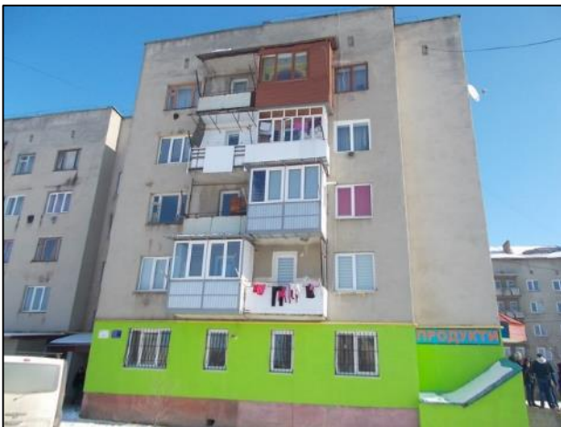
Будівля під час аудиту
