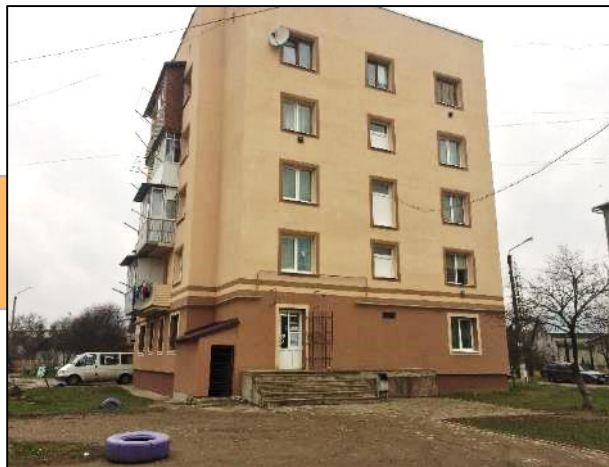
Будівля після утеплення стін
